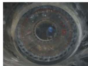
正在安装的新式高效低阻 力金属陶瓷喷嘴环
