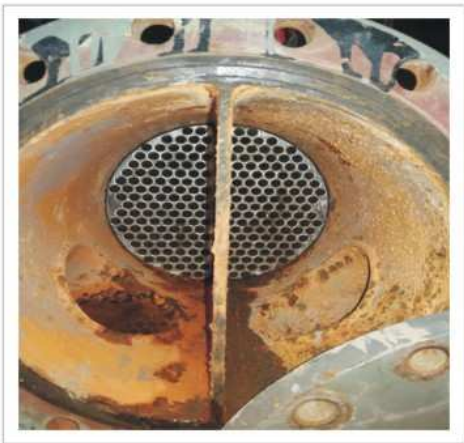
使用物理除垢装置的换热器
